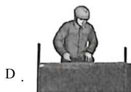
在两桩间拉线砌墙
