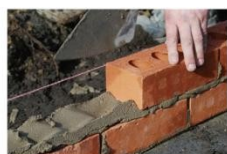
②建筑工人砌墙
